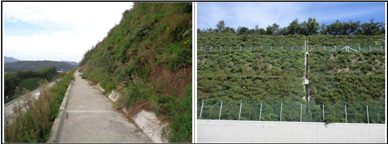
【그림 36.3.3】 배수시설 전경
